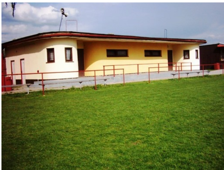
Obrázek 7 Hřiště a zázemí po rekonstrukci z roku 2006
